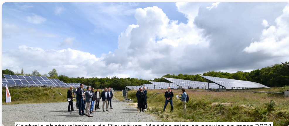
Centrale photovoltaïque de Plounévez-Moëdec mise en service en mars 2021
