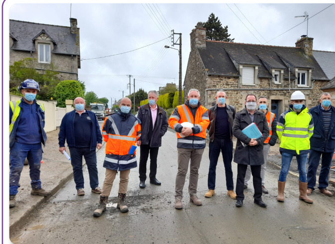
Entreprise Inéo - Mercredi 26 mai à GOMMENEC'H Visite d'un chantier d'aménagement des réseaux électriques, d'éclairage public et des infrastructures de télécommunication
