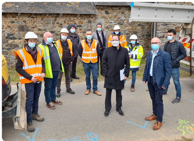
Entreprise Bouygues Énergies et Services Mercredi 24 mars à LA MÉAUGON Visite d'un chantier de renouvellement du réseau électrique basse tension aérien
