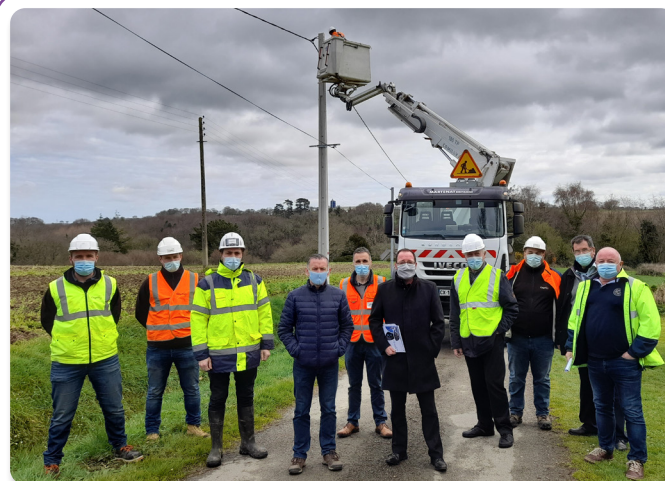
Entreprise Cégélec - Jeudi 25 mars à ROSPEZ Visite d'un chantier de renouvellement du réseau électrique basse tension aérien
