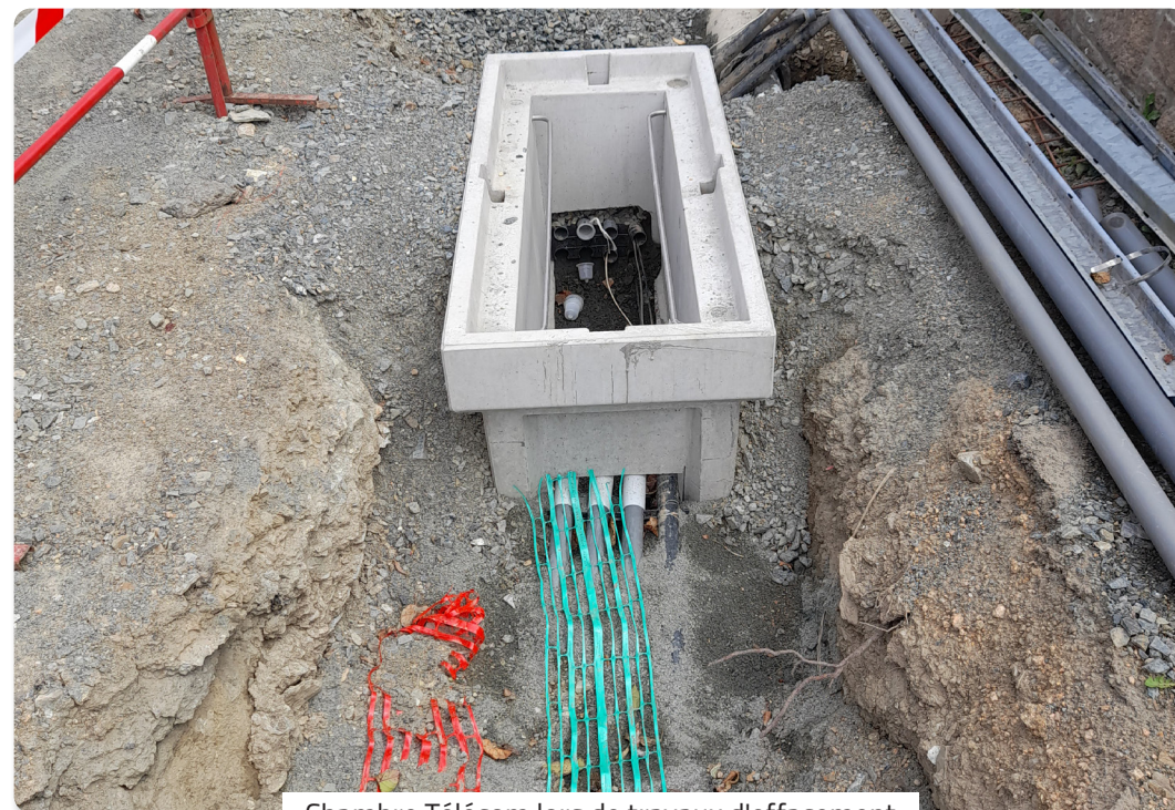
Chambre Télécom lors de travaux d'effacement
