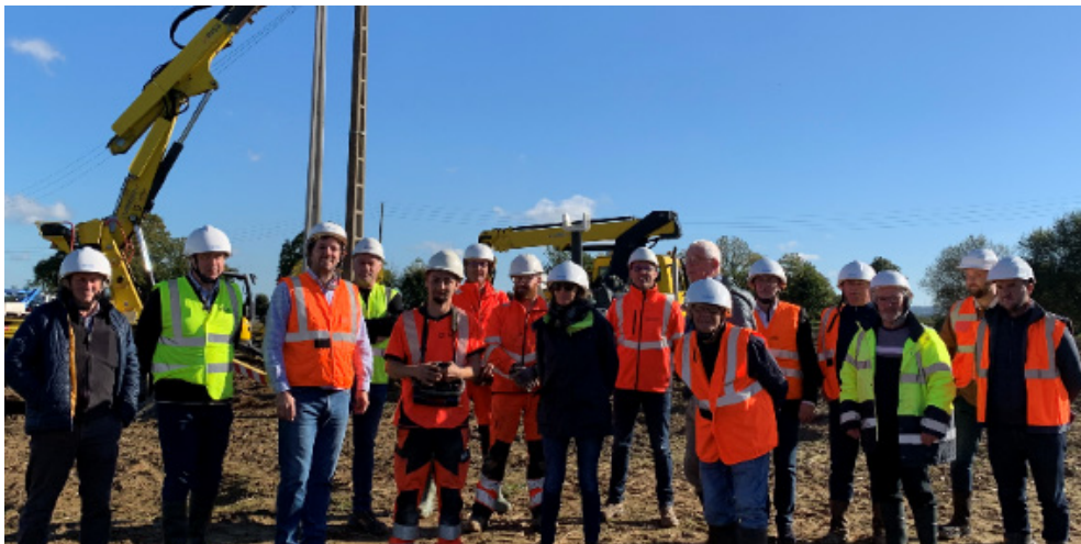
Visite du chantier de Rénovation programmée d'Hénon, le 23 octobre 2024, en présence de M. Andrieux, Président de Lamballe-Terre et mer et maire d'Hénon, M. Robin, Maire de Trédaniel, M. Le Guern, adjoint de la commune de Bréhand, M. Sauvée, adjoint de la commune de Moncontour, Pierrick Briens, vice-président du SDE22, l'entreprise La Sader représentée par Nicolas Badoual, Morgan Almeras et Guenola Chelin-Soulabaille d'Enedis
